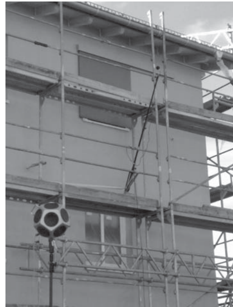
Abbildung 2: Prüfungen am Bau
