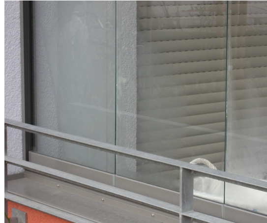
Abbildung 1: Verglaste Schallschutzloggia; zwischen den Scheiben verbleibt ein Luftspalt von ca. 4 mm
