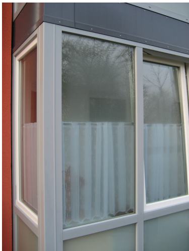
Abbildung 2: Verglaste Schallschutzloggia; Fenster mit umlaufenden Dichtlippen
