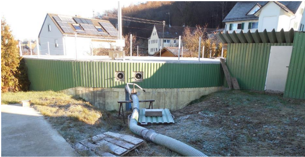
Abbildung 32: Biogasanlage in der Umgebung von Wohnbebauung
